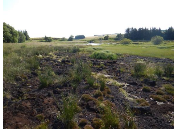
Figure 15 : Décapage de la végétation et du sol dans une zone humide tourbeuse de l'Aubrac (Lozère).
