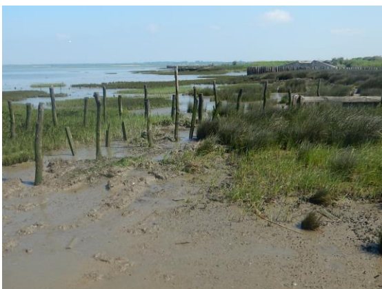
Figure 30 : Vestige d'une digue suite à une dépoldérisation par abandon de la gestion sur une zone humide estuarienne dans le pays de Buch (Gironde).
