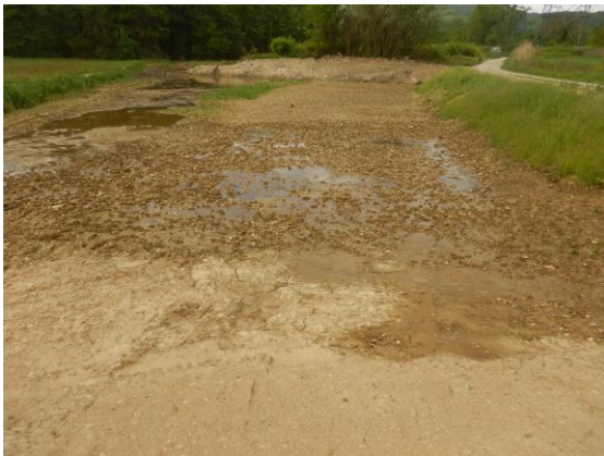
Figure 28 : Déblaiement dans une zone humide alluviale du Grésivaudan (Isère).
