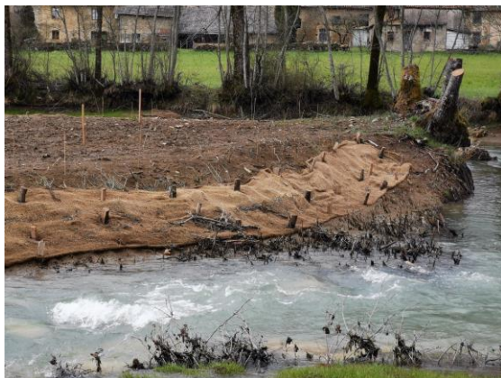
Figure 42 : Reprofilage de berges avec couverture par un textile en fibres naturelles sur une zone humide alluviale du Revermont (Jura).
