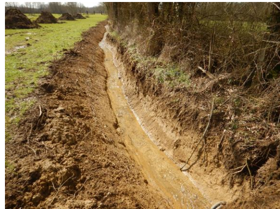
Figure 11 : Curage d'un fossé de drainage dans une zone humide alluviale en Bresse (Ain).
