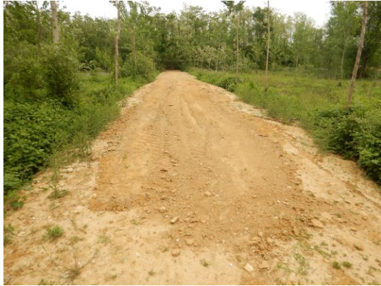
Figure 2 : Remblai et plantation de peuplier sur une zone humide de dépression dans le Val de Saône (Ain).
